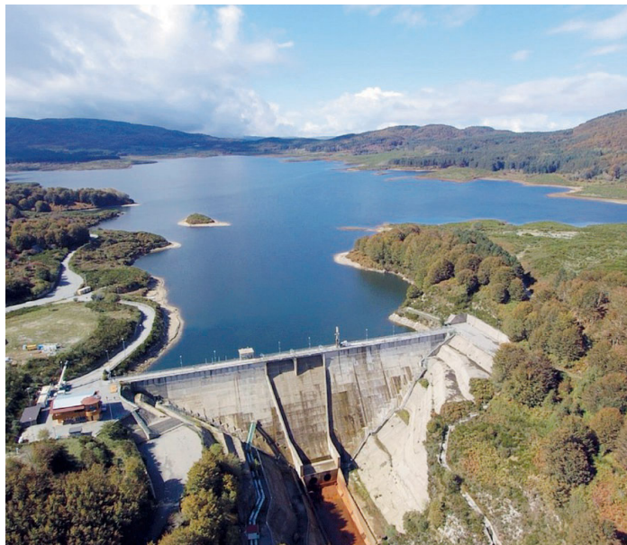
Diga dell'Alaco il bacino artificiale serve per l'approvvigionamento idrico della provincia di Vibo Valentia
