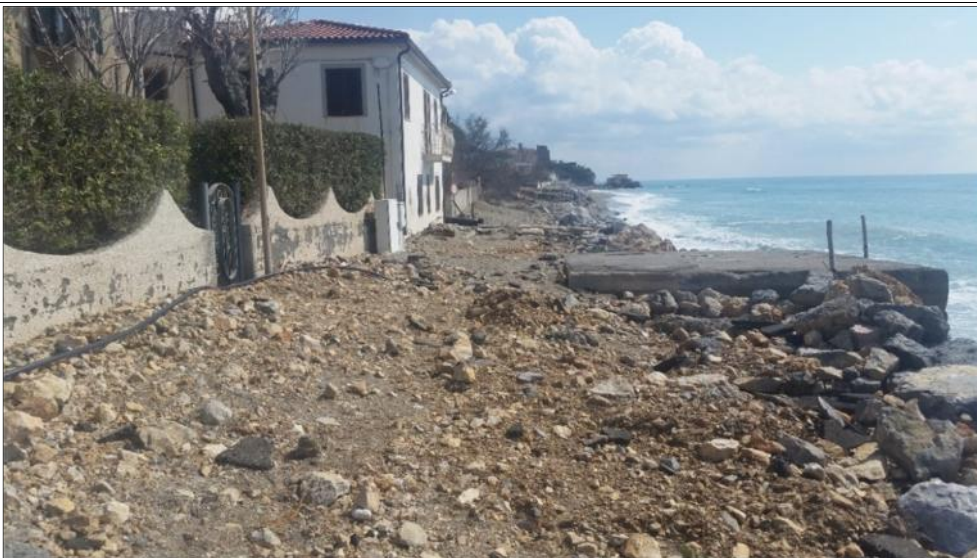
Fig. 35. Bonifati, Cittadella del Capo, la strada lungoriva sotto la stazione ferroviaria di Capo Bonifati è ricoperta dai detriti portati dalla mareggiata.
