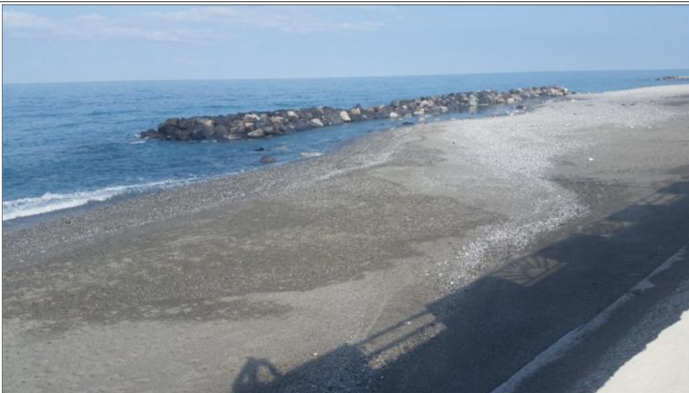
Fig. 3. Amantea, il mare ha asportato la sabbia retrostante i massi frangiflutti.
