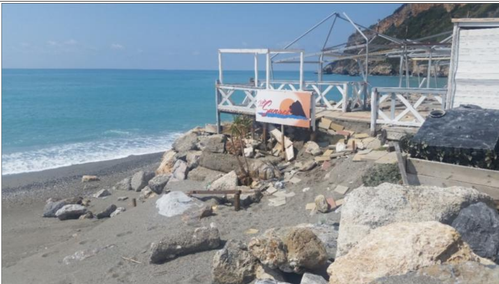
Fig. 29. Cetraro, Lampezia, distruzione di alcune strutture del Lido Sunset.
